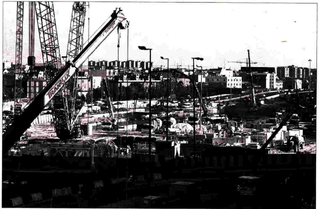
Aspecto de las obras de la M-30, con edificios de viviendas al fondo. / KIKE PARA
